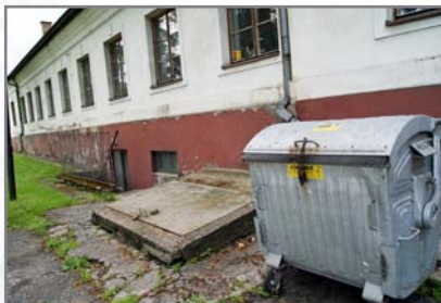
Wejście do piwnicy
