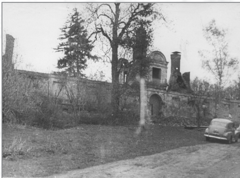
Powojenne zniszczenia budynku do lat 60. XX wieku
