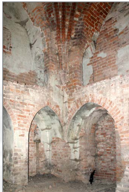
Wnętrze wieży bramnej z kaplicą św. Andrzeja
