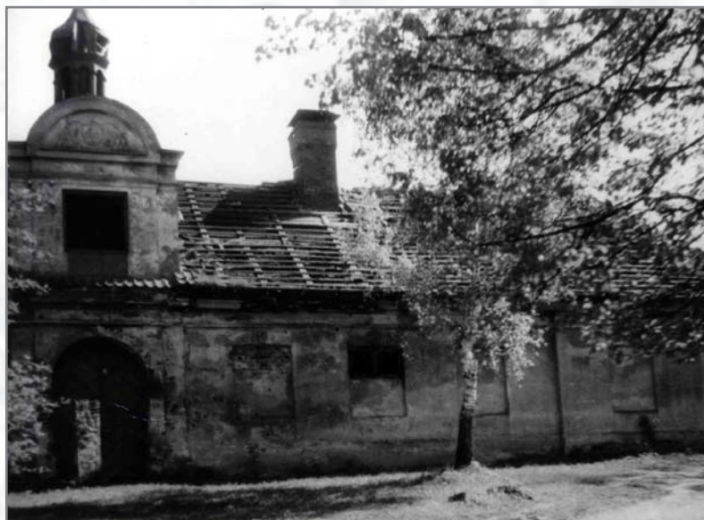
Powojenne zniszczenia budynku do lat 60. XX wieku
