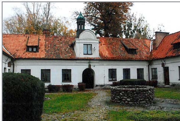
Dom dla konwertytów w Braniewie, zwany potocznie pałacem Potockich po remoncie i adaptacji na Bibliotekę Miejską w latach 80. XX wieku. Widok dziedzińca wewnętrznego
