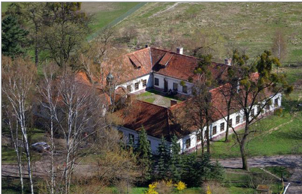
Parterowa budowla na planie kwadratu - ogólny widok założenia z lotu ptaka
