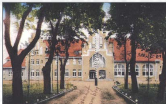
Zabudowania dworca kolejowego. 19 października 1852 roku została uruchomiona linia kolei żelaznej z Braniewa do Królewca
