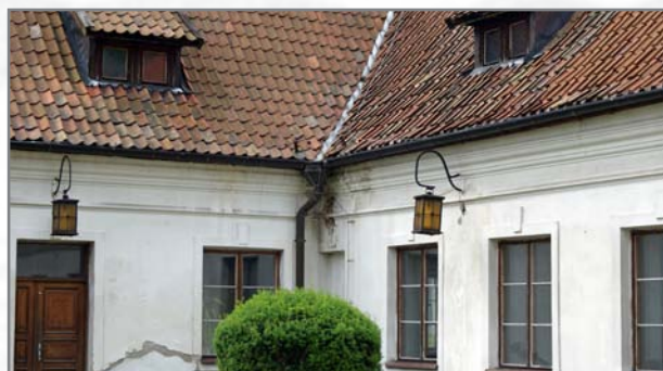
W przejeździe bramnym sklepienie kolebkowe z lunetami
