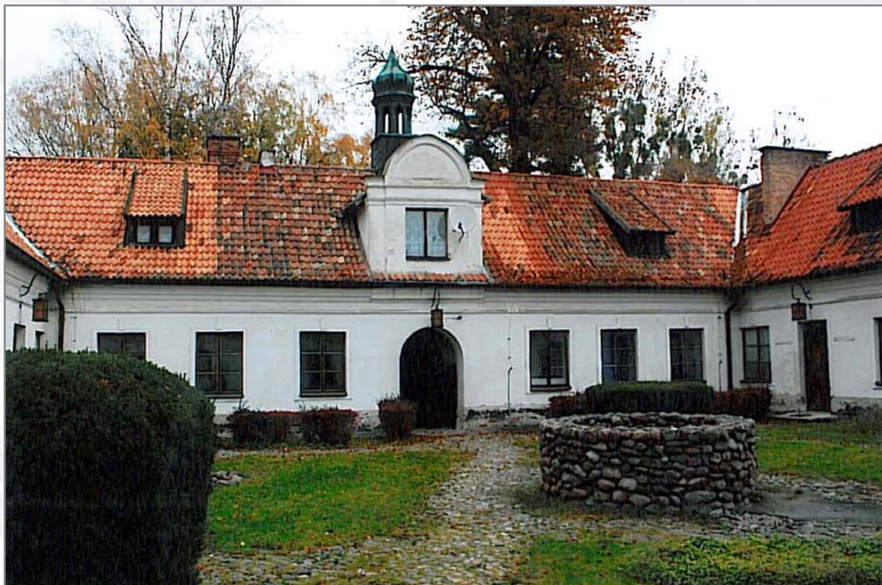
Stan zachowania budynku po pracach adaptacyjno-remontowych w latach 70. XX wieku
